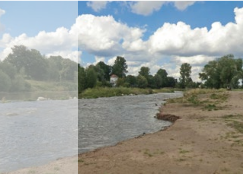
Das 2012/2013 umgebaute Wehr Höchst
