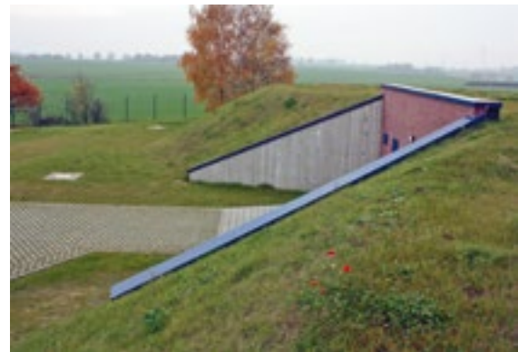
Der Reinwasserbehälter in neuem Gewand
